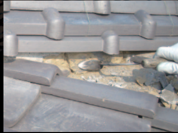
② 既存漆喰解体
